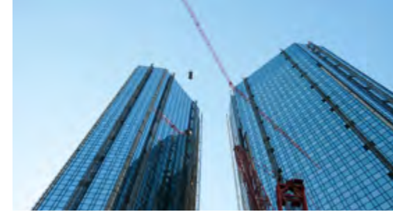
Hijsen met bouwkraan
