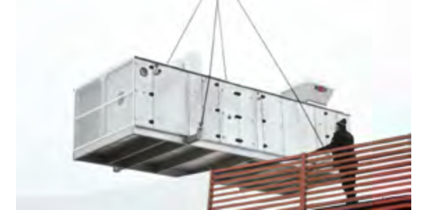
Dakcentrale op het dak van een landelijk restaurantketen
