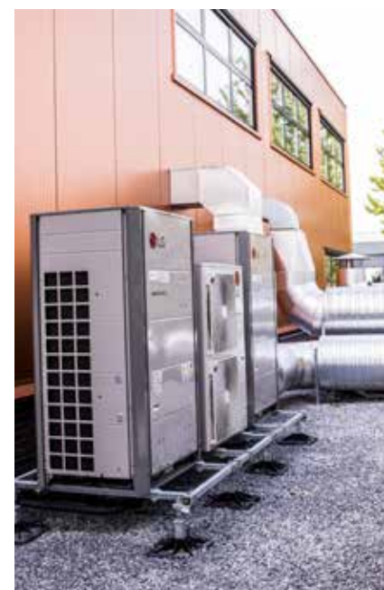
De warmtepomp, luchtbehandelingskast en buitendelen van het VRF-systeem zijn mooi opgesteld aan de zijkant van het pand.
