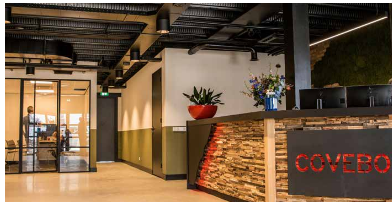
Op de begane grond zijn elf cassettes geïnstalleerd in de ontvangstruimte, spreekkamers en bedrijfsbar.
