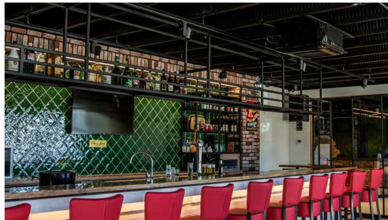
De VRF-systemen bestaan uit één buitendeel en meerdere binnendelen die, in de vorm van vierzijdige cassettes, netjes over het pand zijn verdeeld.
